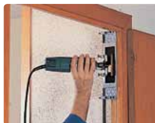
Фрезерование на дверной коробке (Модель АО93)
