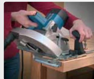
Выполнение наклонного реза.
