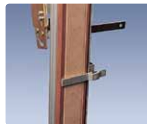
Закрепление дверной коробки в шаблоне
