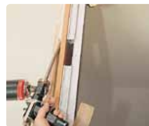
Заполнение полиуретановой пеной.
