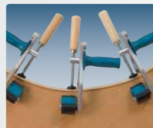
Фиксирование торцевых накладок на вогнутых панелях
