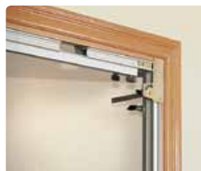
Установка наличников с помощью соответствующих упоров.
