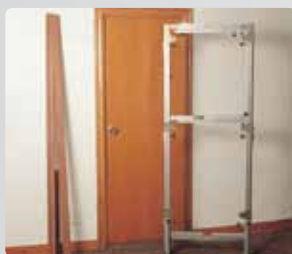
Надежная фиксация благодаря полиуретановой пене
