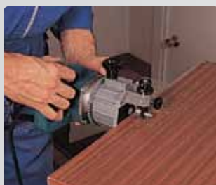
Снятие свесов кромочного материала
