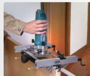
Фрезерование посадочного места верхней петли в полотне двери.
