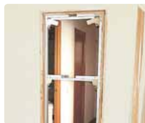
Установка шаблона PB83E, вровень с проемом.
