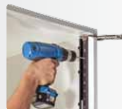
Отверстия для установки дверных петель.
