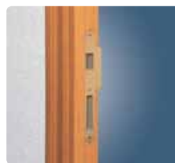
Использование UC16K и FR66P позволяет выполнять посадочное место для накладной планки на коробке и паз под язычок замка и ручки
